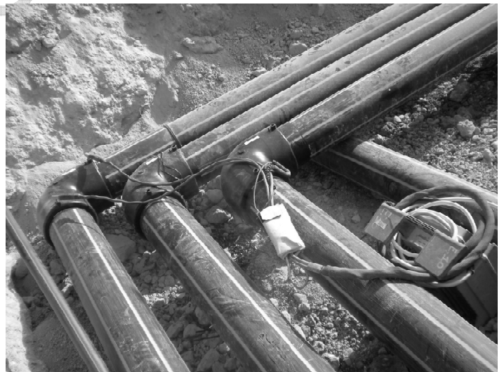
Figura 12. Soldadura por electrofusión. Soldadura con manguito electrosoldable
