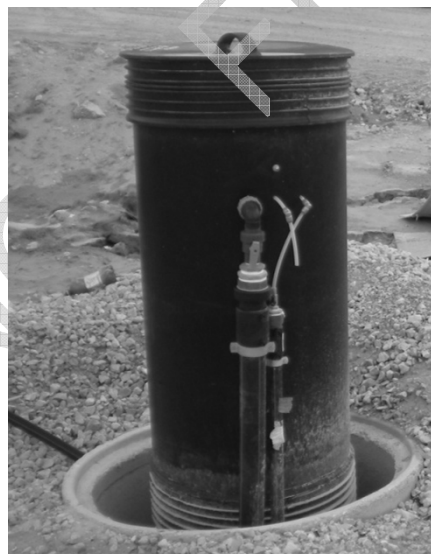
Figura 14. Vista de un pozo de captación de condensados. Conexión y vista general
