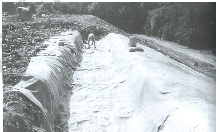
Figura 31. Construcción de la zanja de anclaje perimetral
